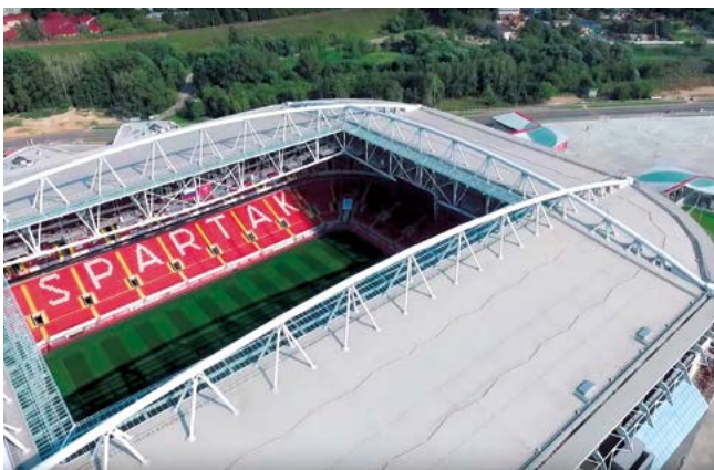
Sân vận động Spartak Moscow, Moscow, Nga LOGICROOF V-RP 1.2 mm | 36.000 m 2
