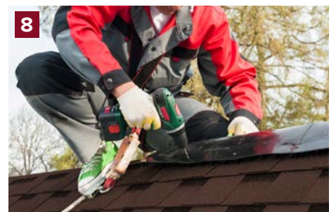
Lắp lỗ thông hơi trên nóc nhà để loại bỏ độ ẩm dư thừa.
