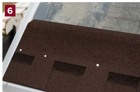
Trước khi lắp ván lợp vào phần mái nhô ra của đầu hồi, hãy phủ một lớp mastic FIXER lên trên.
