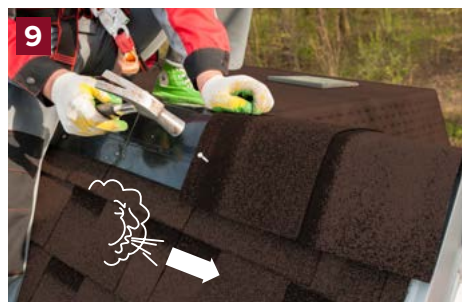
Che lỗ thông gió trên nóc nhà bằng ván lợp hông và ván lợp nóc nhà. Ván lợp phải được lắp bắt đầu từ phía đối diện với hướng gió vào.
