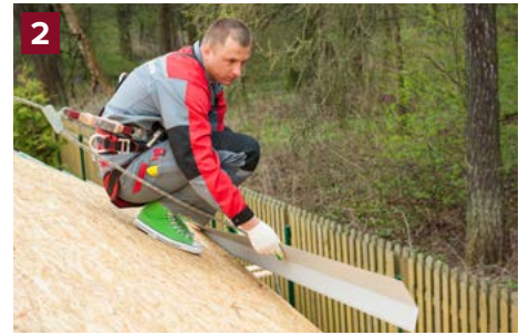
Lắp đặt máng xối ở mái hiên để thoát nước ra khỏi sàn gỗ.
