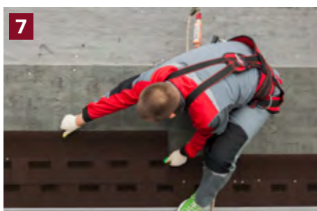
Đặt các tấm lợp theo thứ tự bất kỳ, dịch chuyển các lớp chồng lên nhau theo chiều dọc ít nhất 15 cm.
