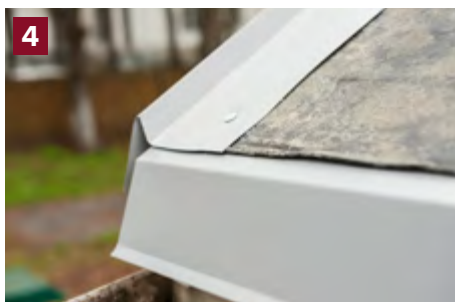
Lắp tấm chắn sóng để gia cố phần nhỏ ra ở cuối.
