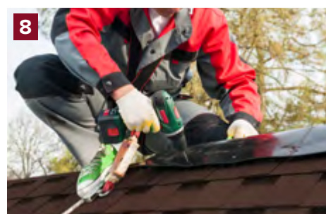
Lắp một lỗ thông hơi trên nóc mái để loại bỏ độ ẩm dư thừa.
