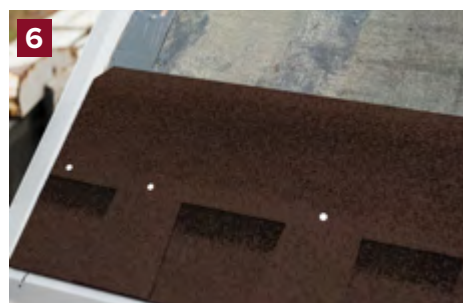
Trước khi đặt ván lợp vào phần đầu hồi nhỏ ra, hãy phủ chúng bằng keo dán FIXER.
