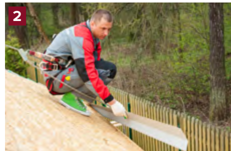
Lắp một tấm chắn mái hiên để thoát nước ra khỏi sàn gỗ.
