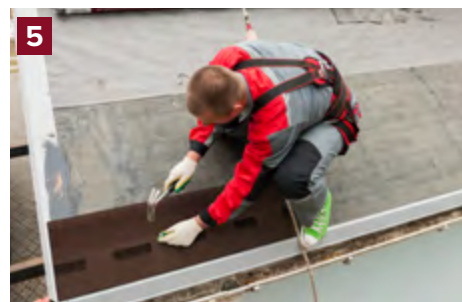
Cố định các tấm ván lợp bằng đinh lợp mái chuyên dụng có đầu rộng.
