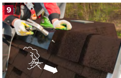
Che lỗ thông hơi bằng ván lợp úp nóc và úp sườn. Các tấm ván lợp sẽ được đặt bắt đầu từ phía đối diện với hướng gió thổi.
