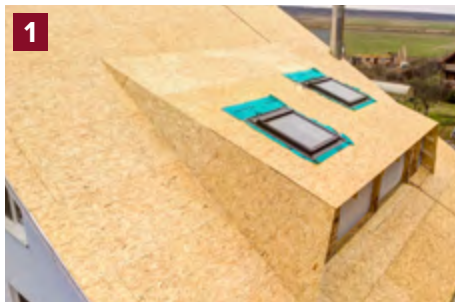
Chuẩn bị sàn gỗ khô và bền (ván ép chống nước, ván OSB-3, ván ghép có lưới và rãnh).
